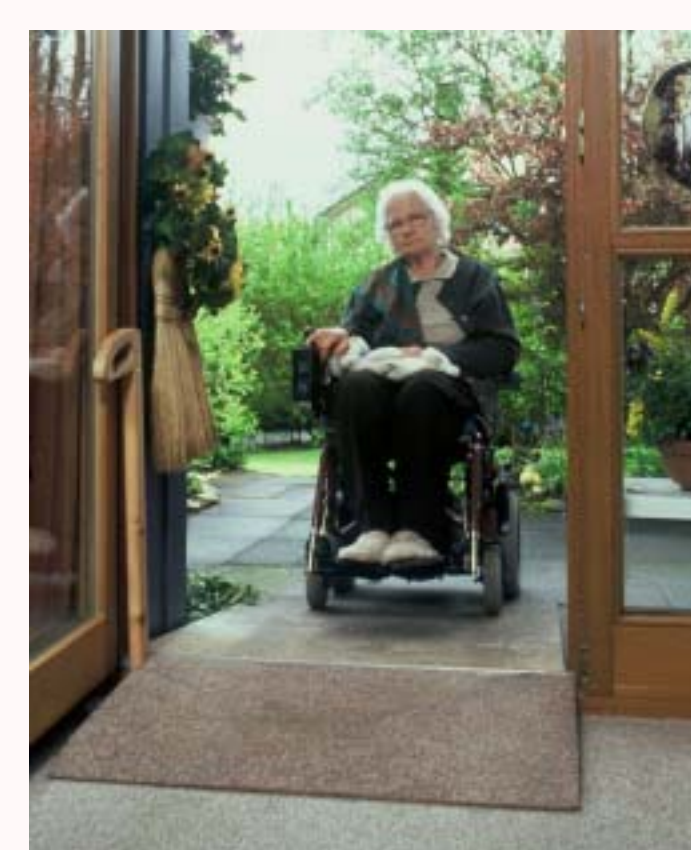
Rampe beseitigt die Schwelle zur Terrasse
