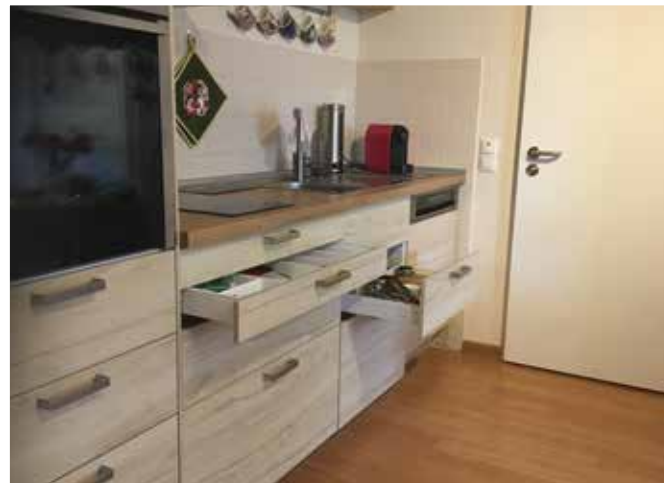
Einbau von Schubladen (statt Unterschränken mit Drehtüren)
