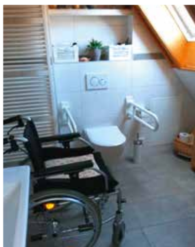
Überfahbares WC mit Stützklappgriffen
