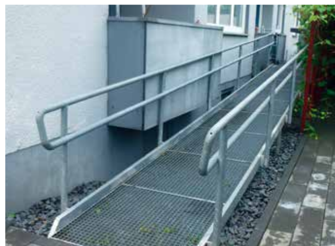
Einbau einer Rampe – Erschließung über Balkon
